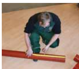
2. Übertragung des Abstandes auf die 6 m Rohrstanze.
