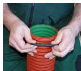
4. Anlegen der Dichtung auf das Rohrstück.
