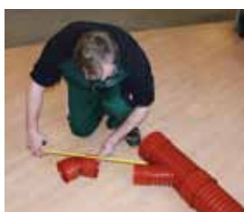
1. Abmessen des Abstandes für das Zwischenrohr.
